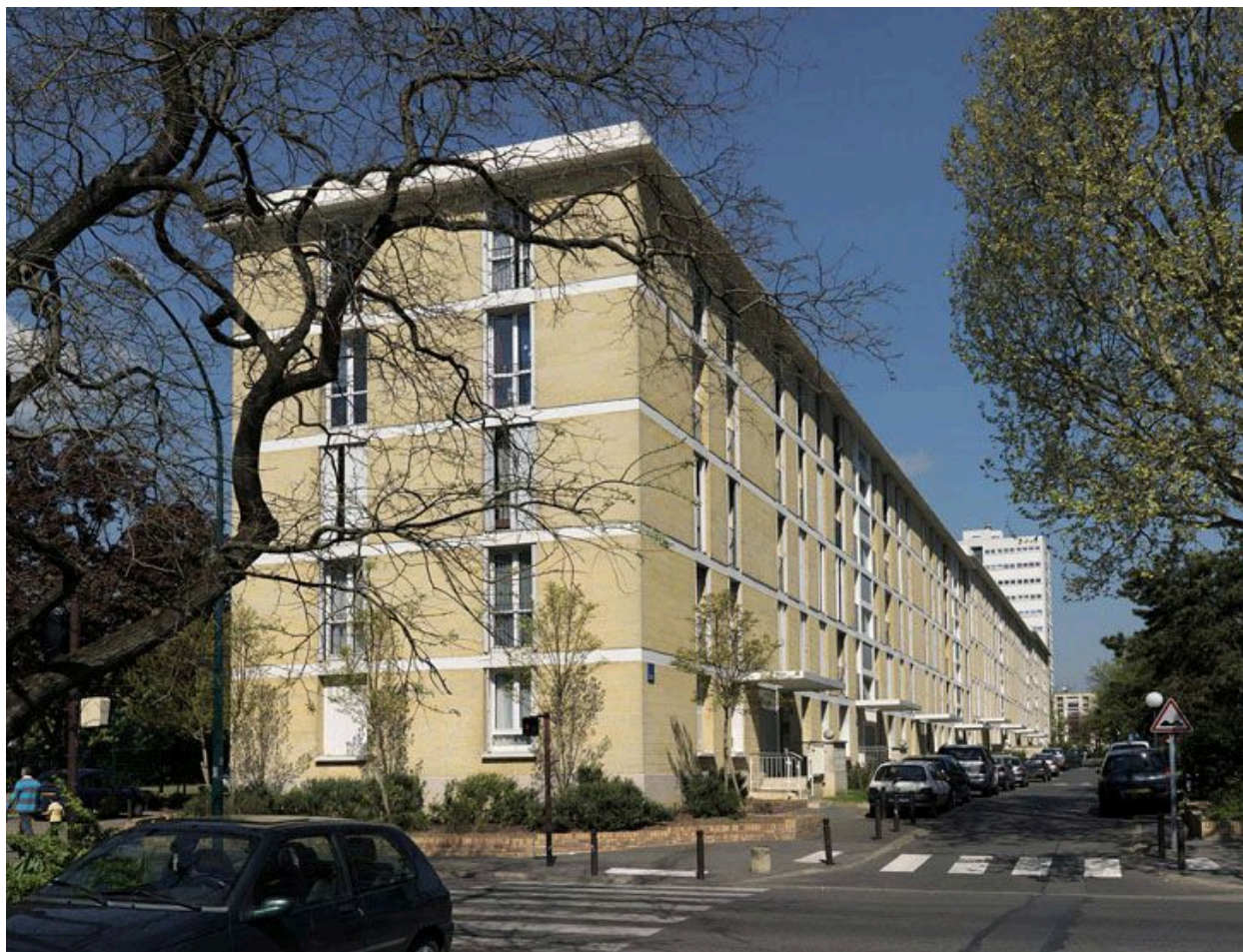
Vue générale de la barre D.
