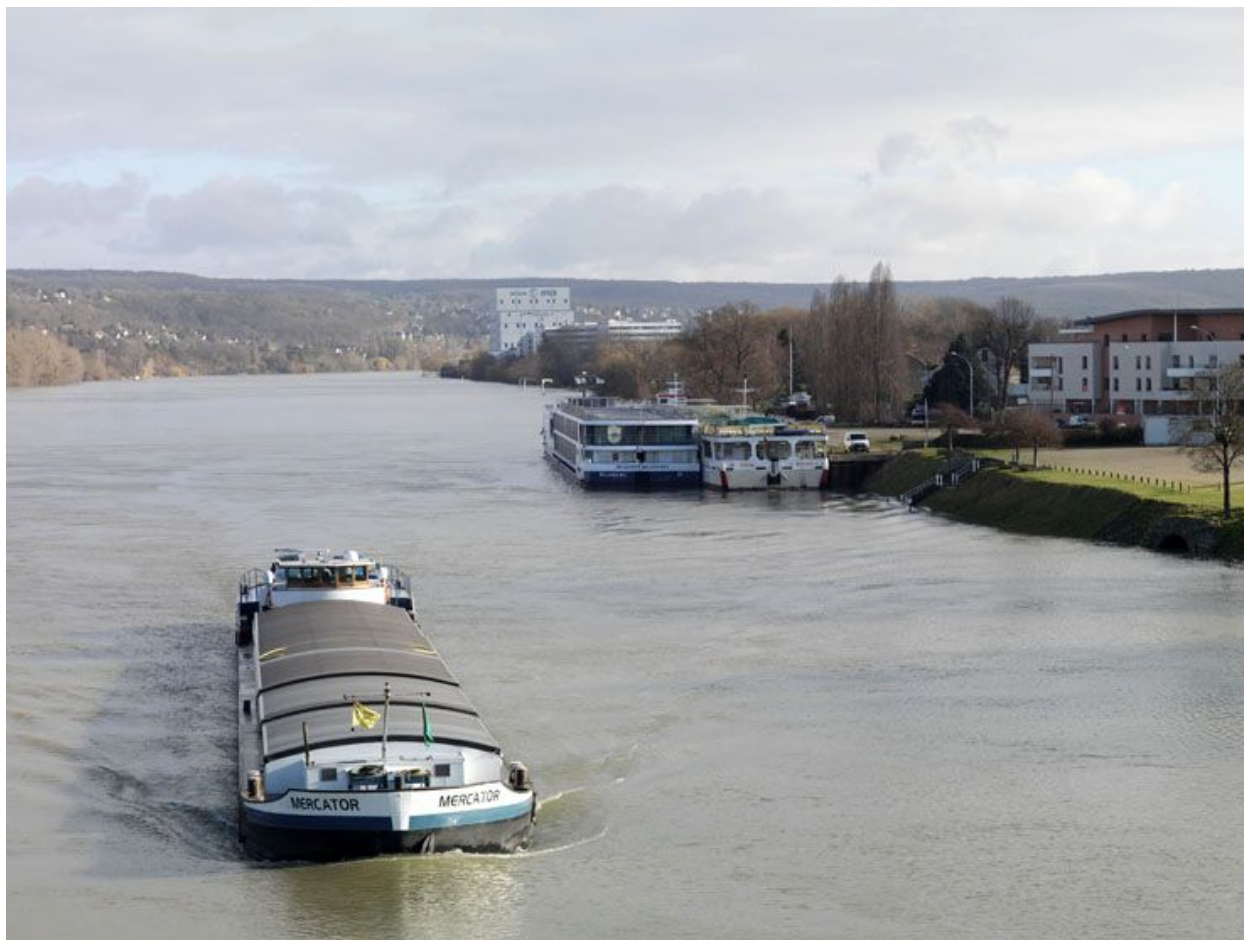
Les Mureaux : sur le pont Rhin et Danube.
