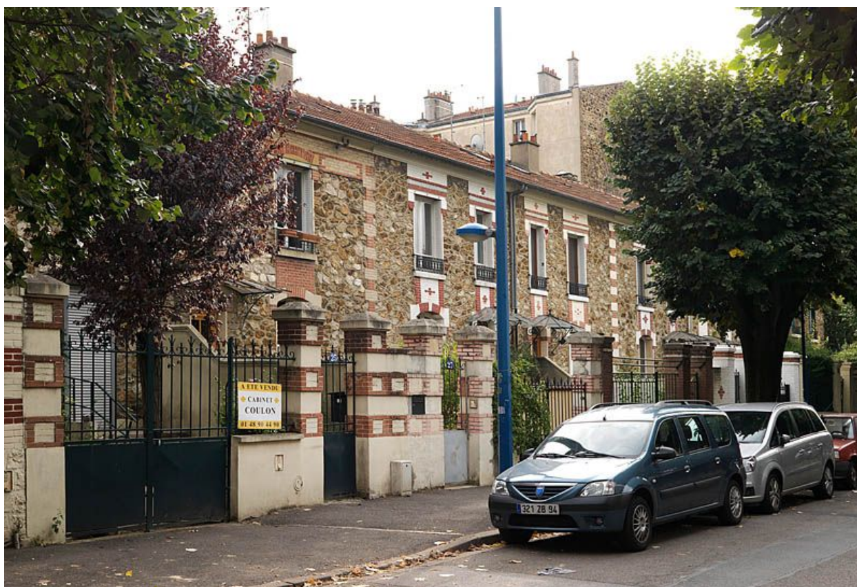
Choisy-le-Roi, lotissement concerté, 21 à 35 avenue Marcel David. Vue d'ensemble.
