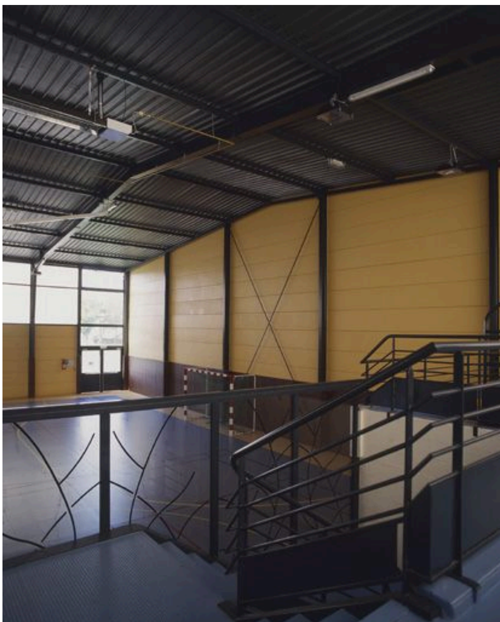
L'escalier d'accès à la tribune de la salle omnisports.
