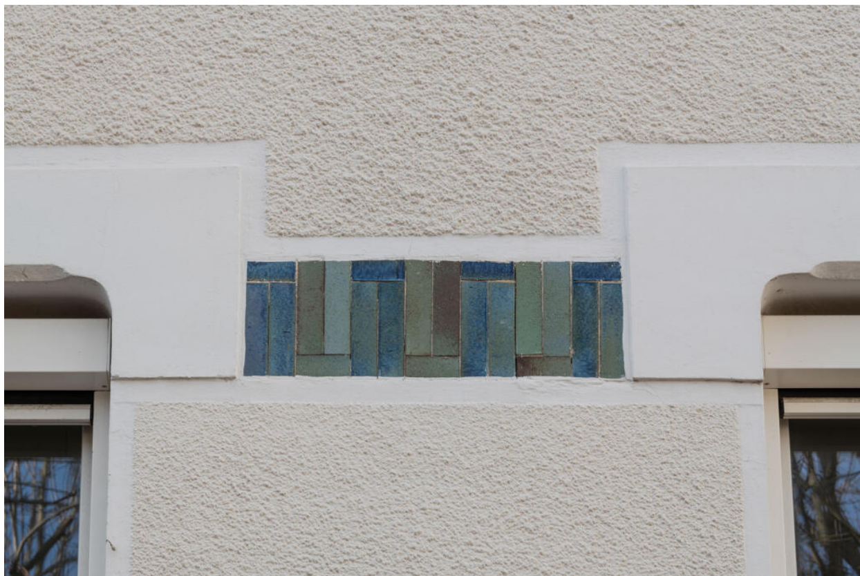
École des Coteaux, bâtiment de 1922, décor en brique émaillée
