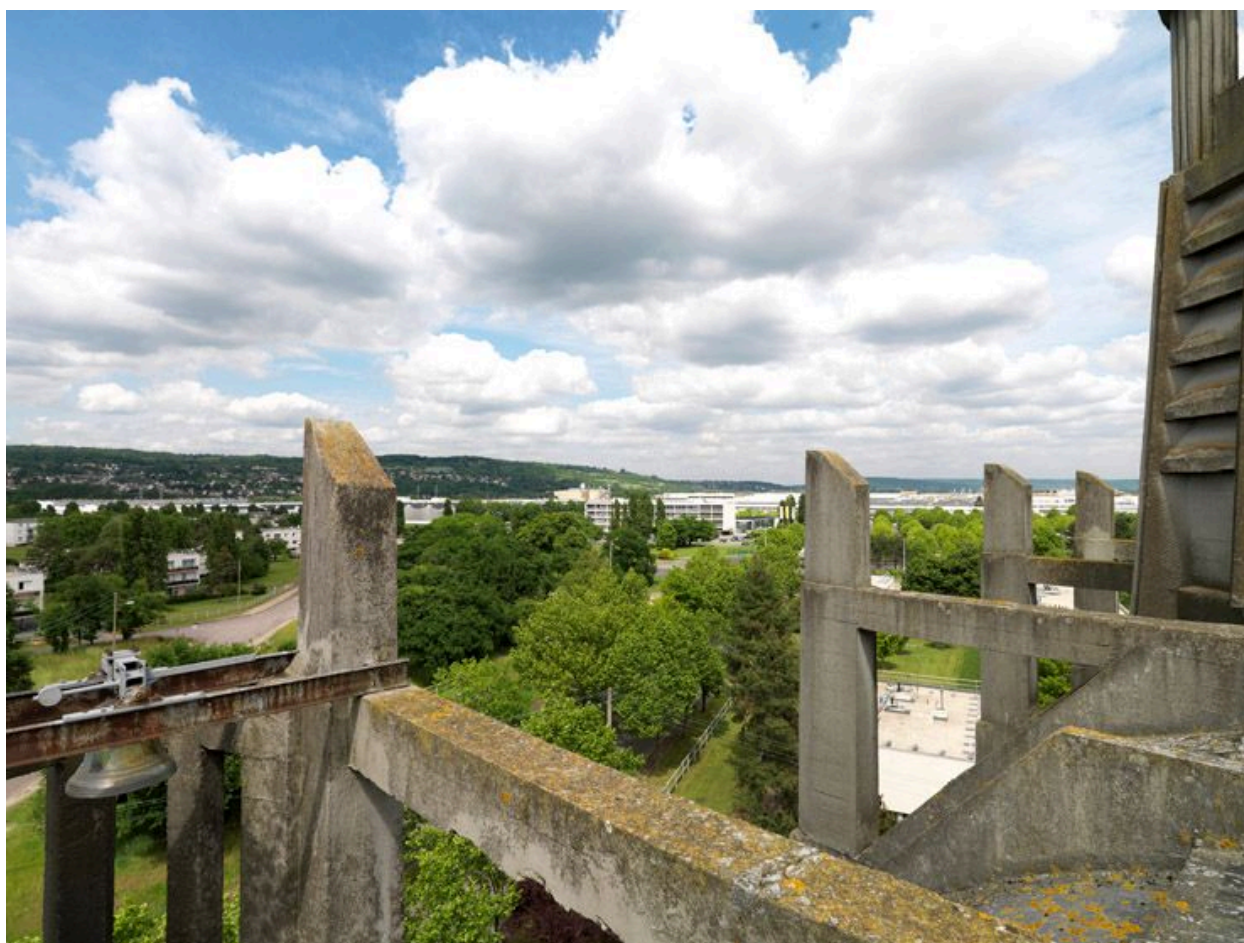
Système de contrebuttement de l'église.
