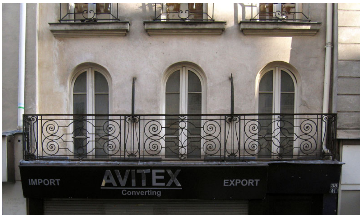
Vue du balcon alternant panneaux et pilastres à motifs de lyre stylisés, 39-41, rue de Cléry.
