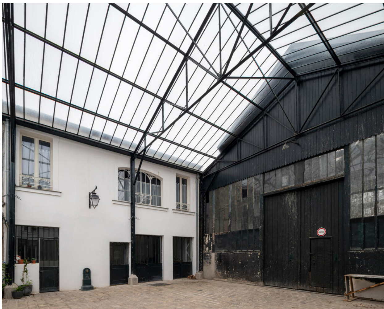
Cour centrale couverte. À droite, l'entrée de l'atelier des forges.
