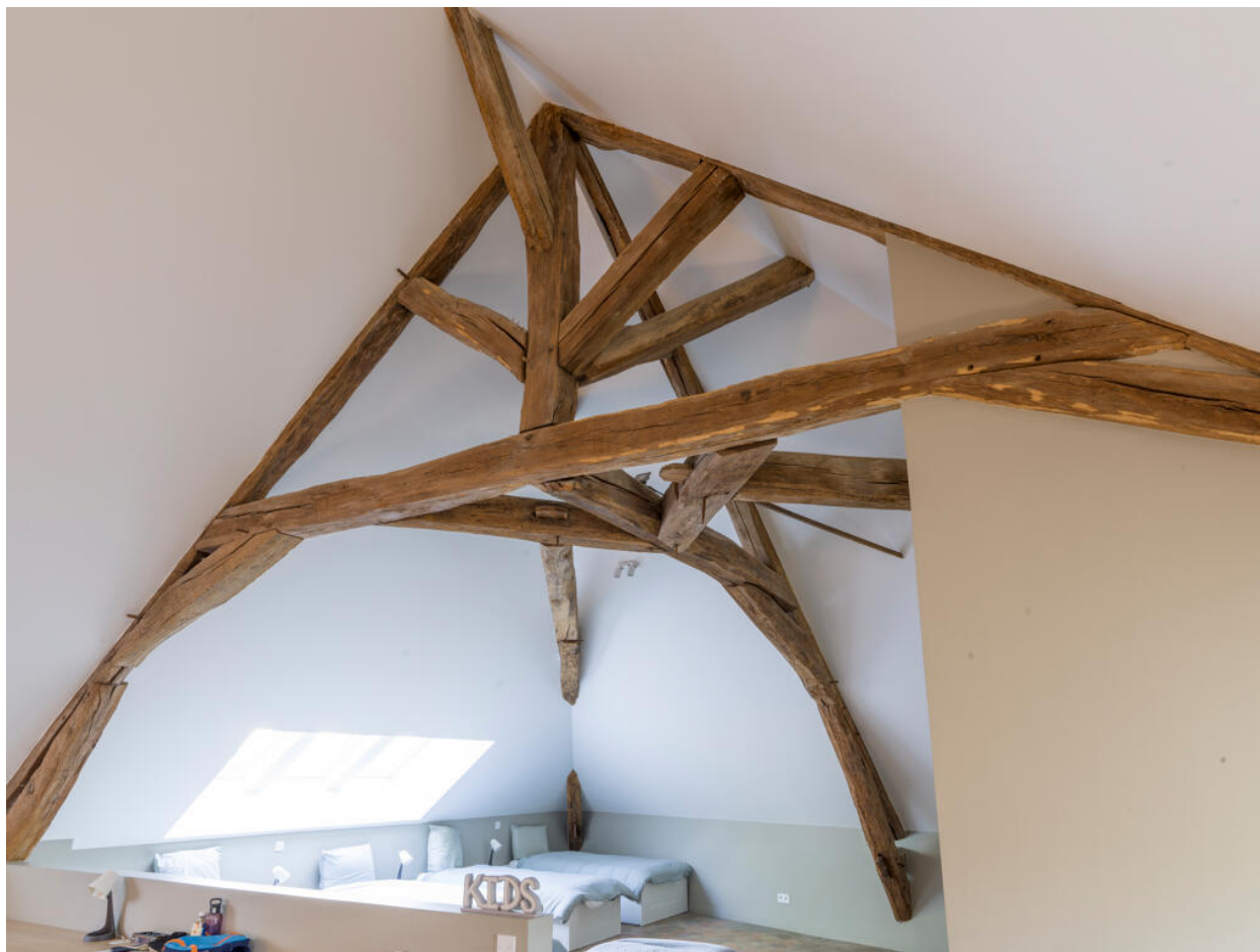
Vue générale de la ferme de charpente située dans la partie sud du comble.
