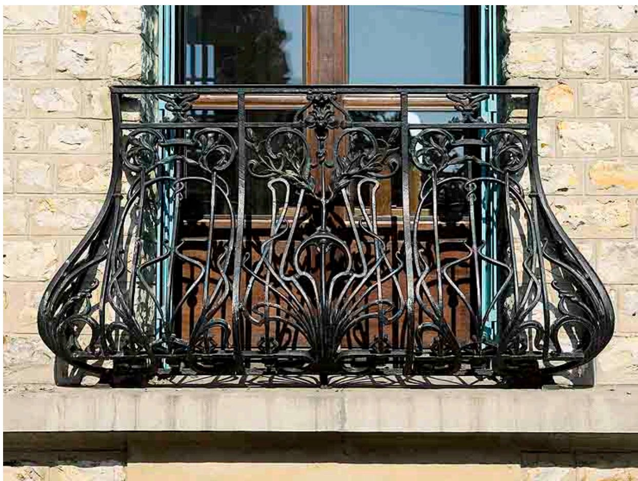
Détail de l'un des garde-corps de ferronnerie traité dans un style Art nouveau.
