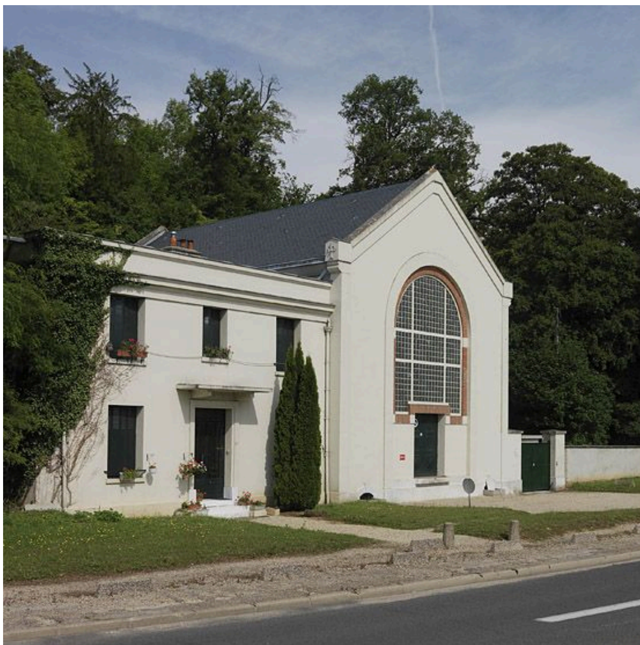
Station de pompage et logement de contremaître.
