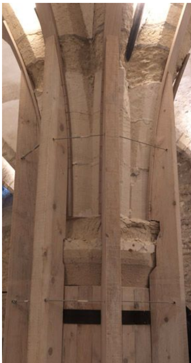
La salle voûtée du sous-sol : chapiteau d'une colonne centrale avec étaieiment.
