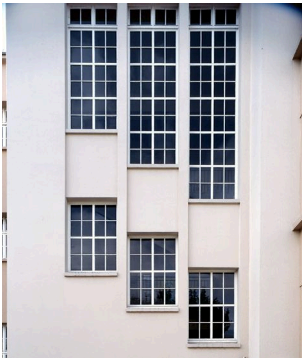
L'école primaire : détail des baies de l'escalier, sur la façade arrière.
