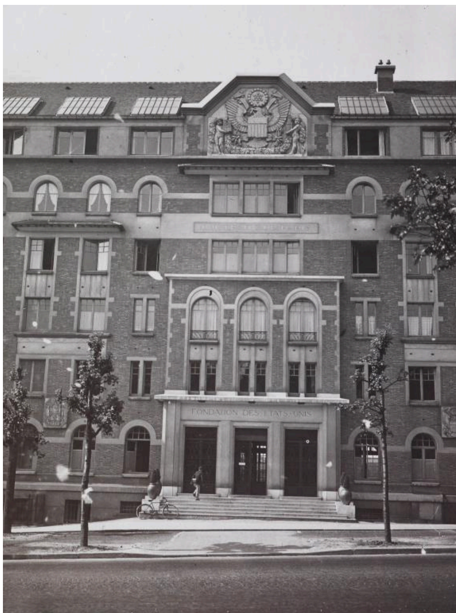
L'entrée de la fondation sur le boulevard Jourdan, s. d. Photographie. Larousse (photographe). CIUP, centre de valorisation du patrimoine, P/TP-B17-0485.
