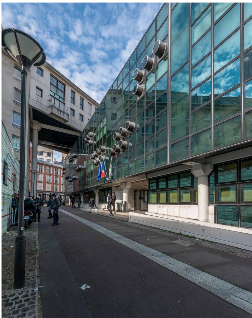
La façade du lycée tournée vers l'intérieur de l'îlot.
