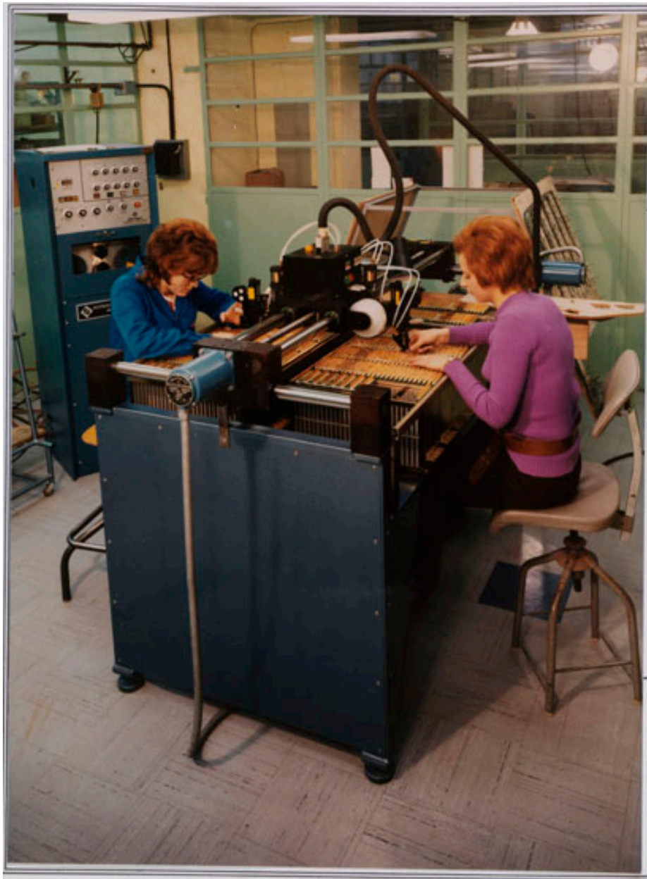
Photo ancienne. Deux femmes conduisent une machine à câbler semi-automatique pour standards téléphoniques. Photographie J-S, 1971.
