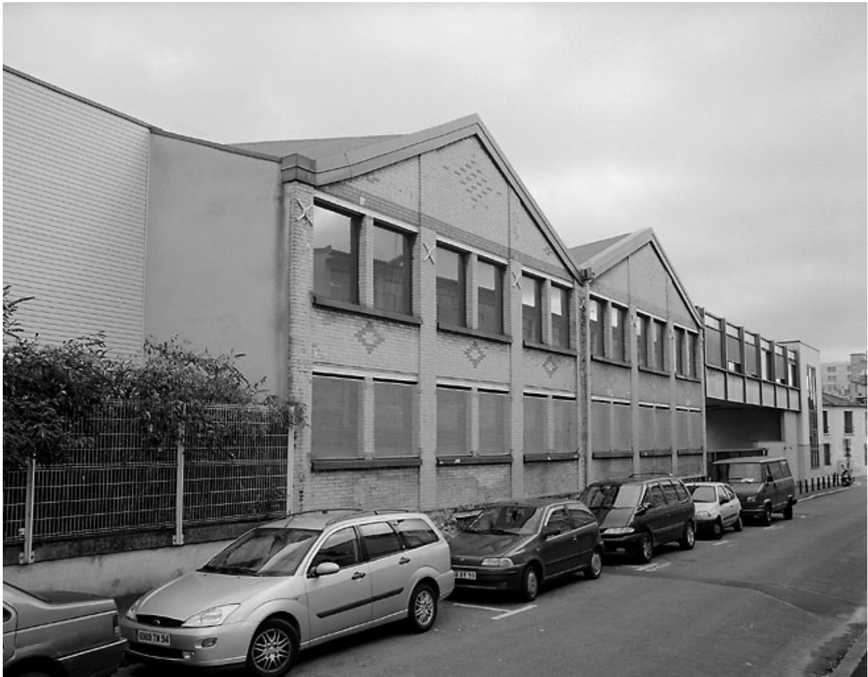
Halles de la papeterie SCOPAM, 28 rue du Progrès.
