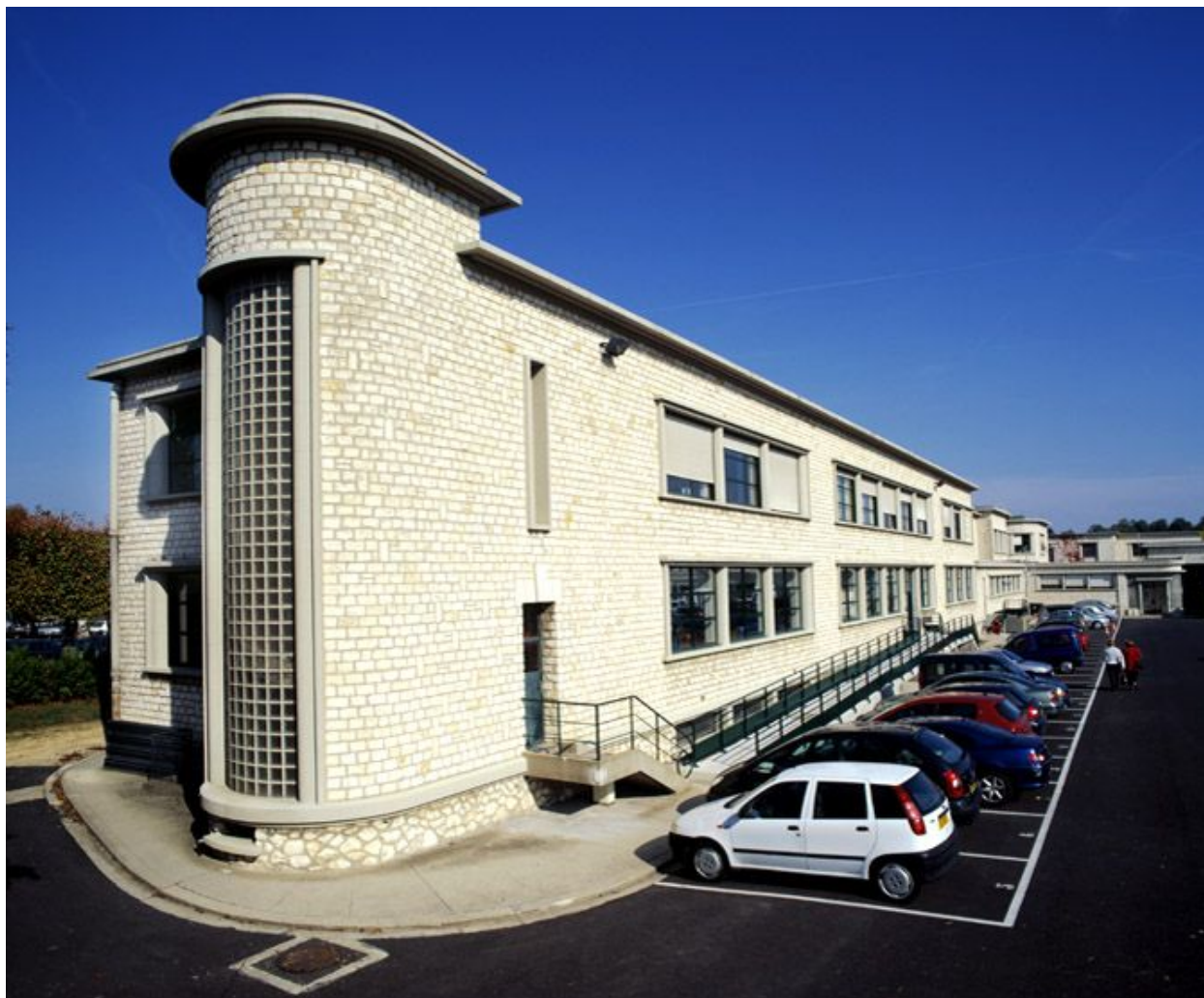
Angle occidental de l'aile nord (bureaux de l'administration), vue depuis la cour.
