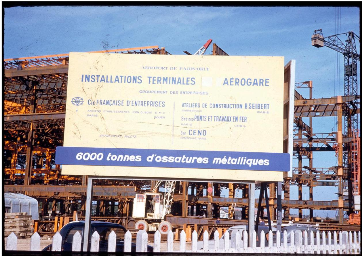
1957 1961, la construction des Installations Terminales, l'ossature métallique en 1959, Panneau présentant les entreprises travaillant sur le chantiers et l'ampleur de la réalisation: 6000 tonnes d'acier vue prise depuis le nord est.
