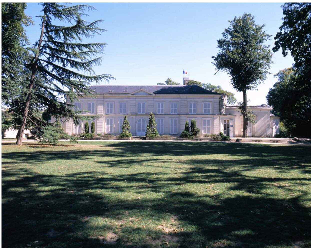
Vue d'ensemble de la façade sur le parc.
