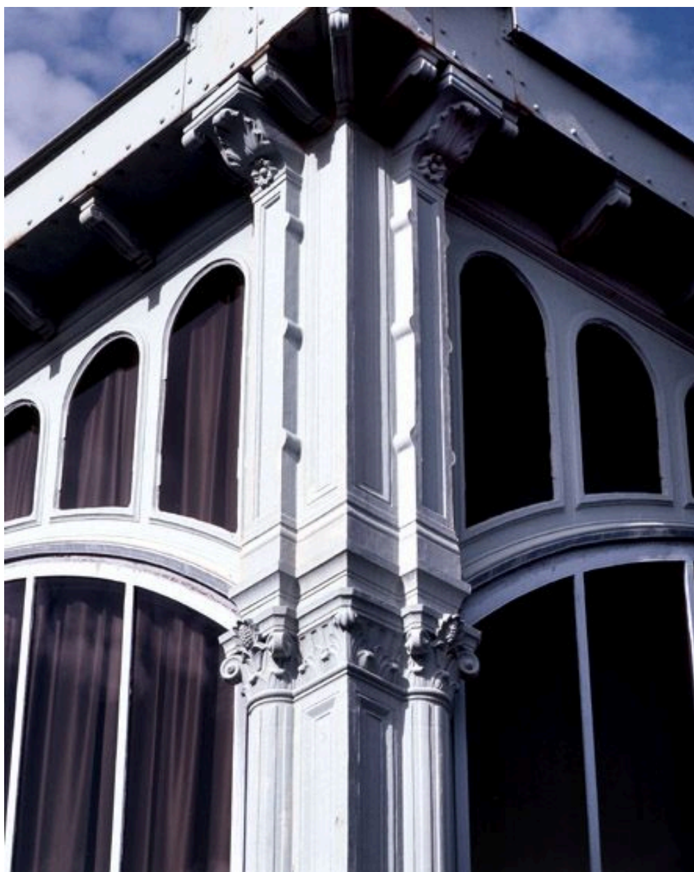
Détail d'un angle du bâtiment.
