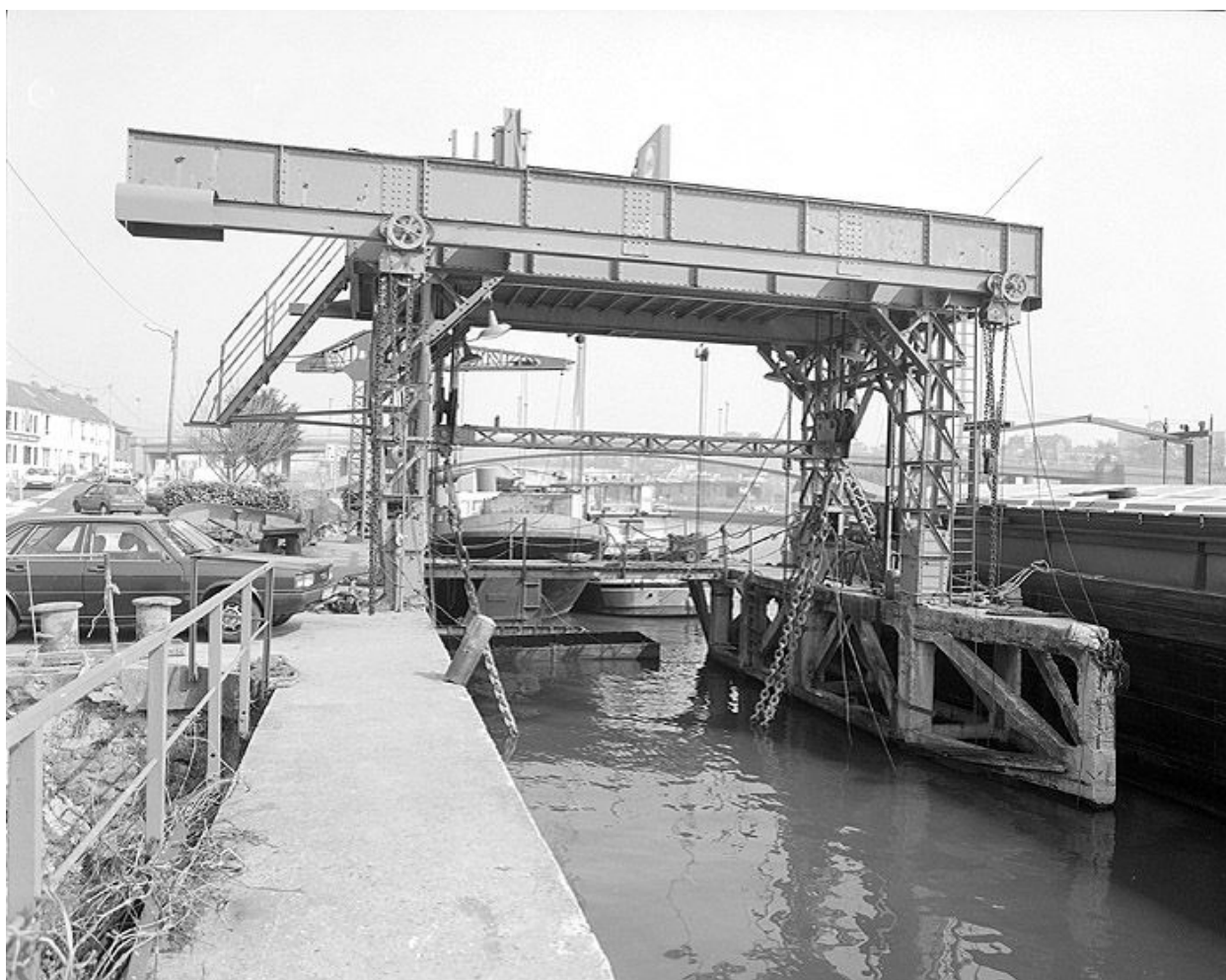
Portique de levage pour réparation des remorqueurs.
