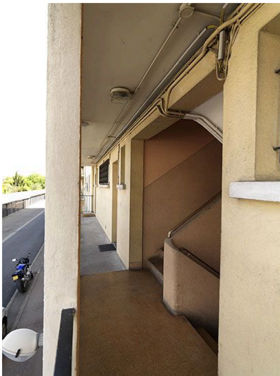
Vitry-sur-Seine, cité dite résidence les Rosiers, 172-184 rue Gabriel-Périi. Vue d'une coursive.
