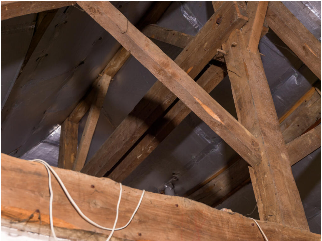
Détail de la charpente du 25 rue Saint-Pierre.
