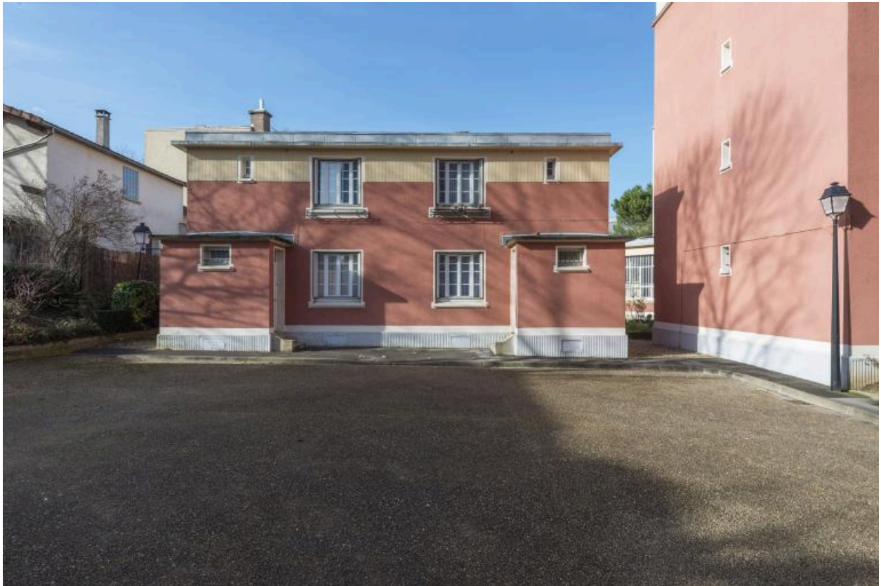
Vue des ateliers situés au rez-de-chaussée (3)
