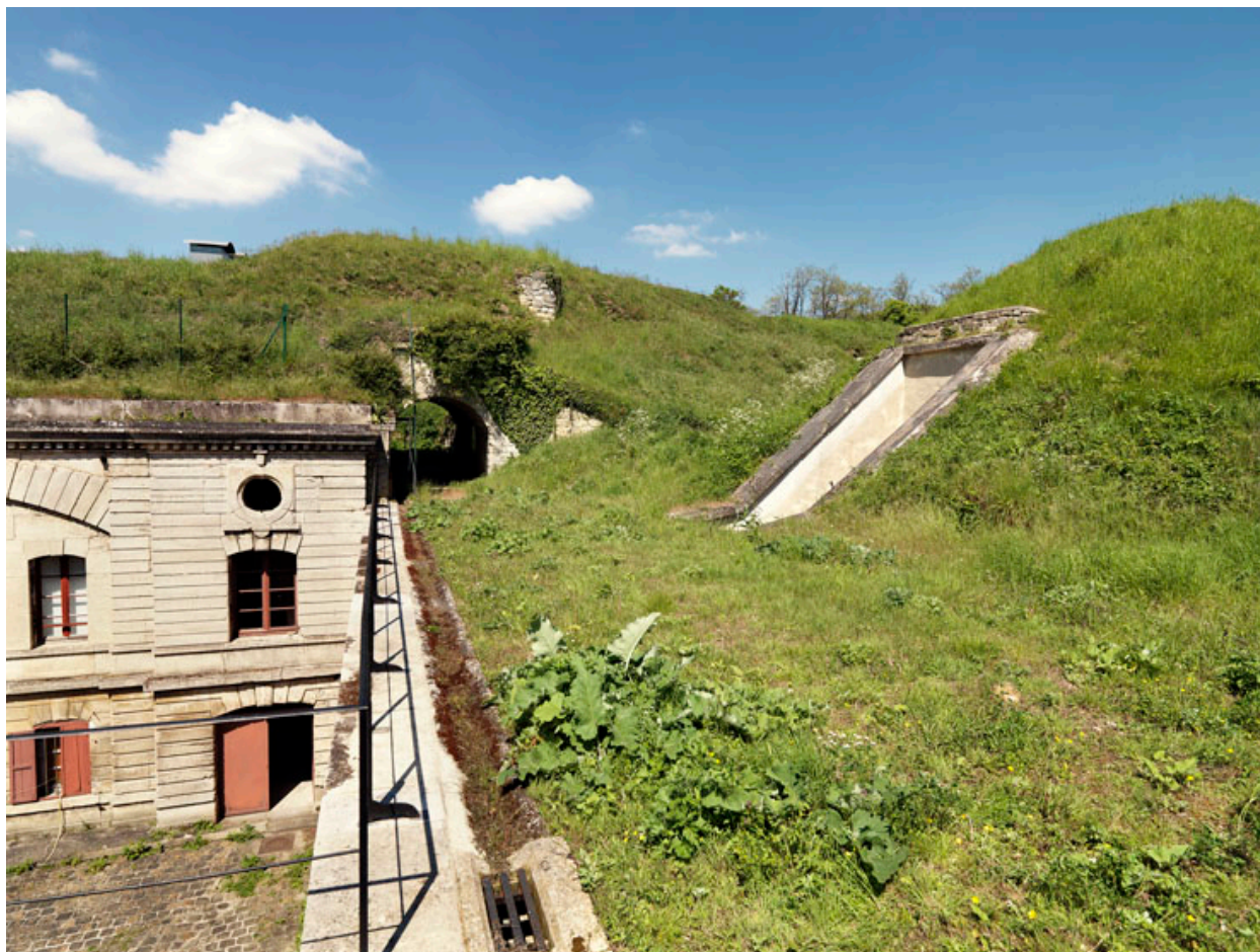
Le sommet des bâtiments, à l'est.
