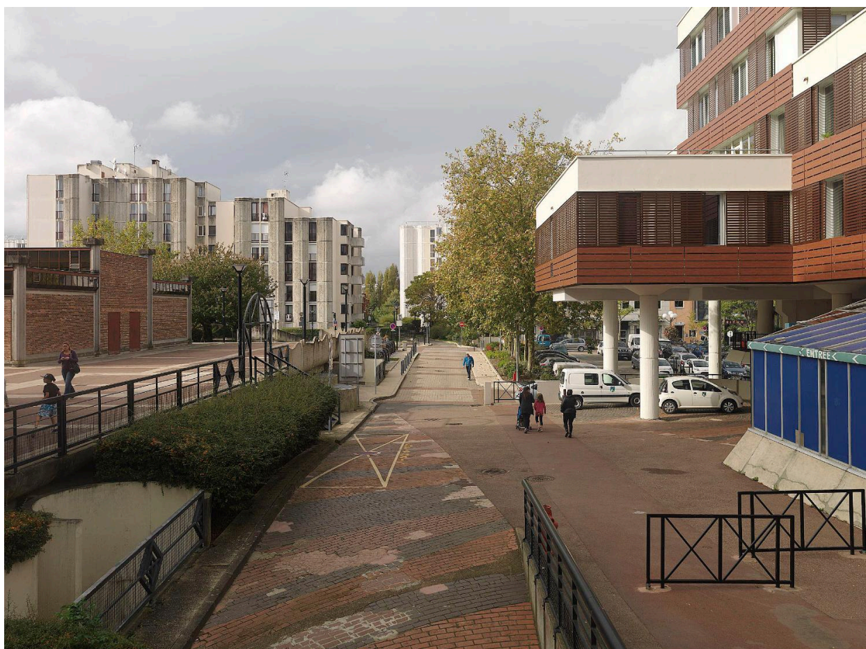
L'entrée de la dalle des Sept-Mares, du côté du centre administratif.
