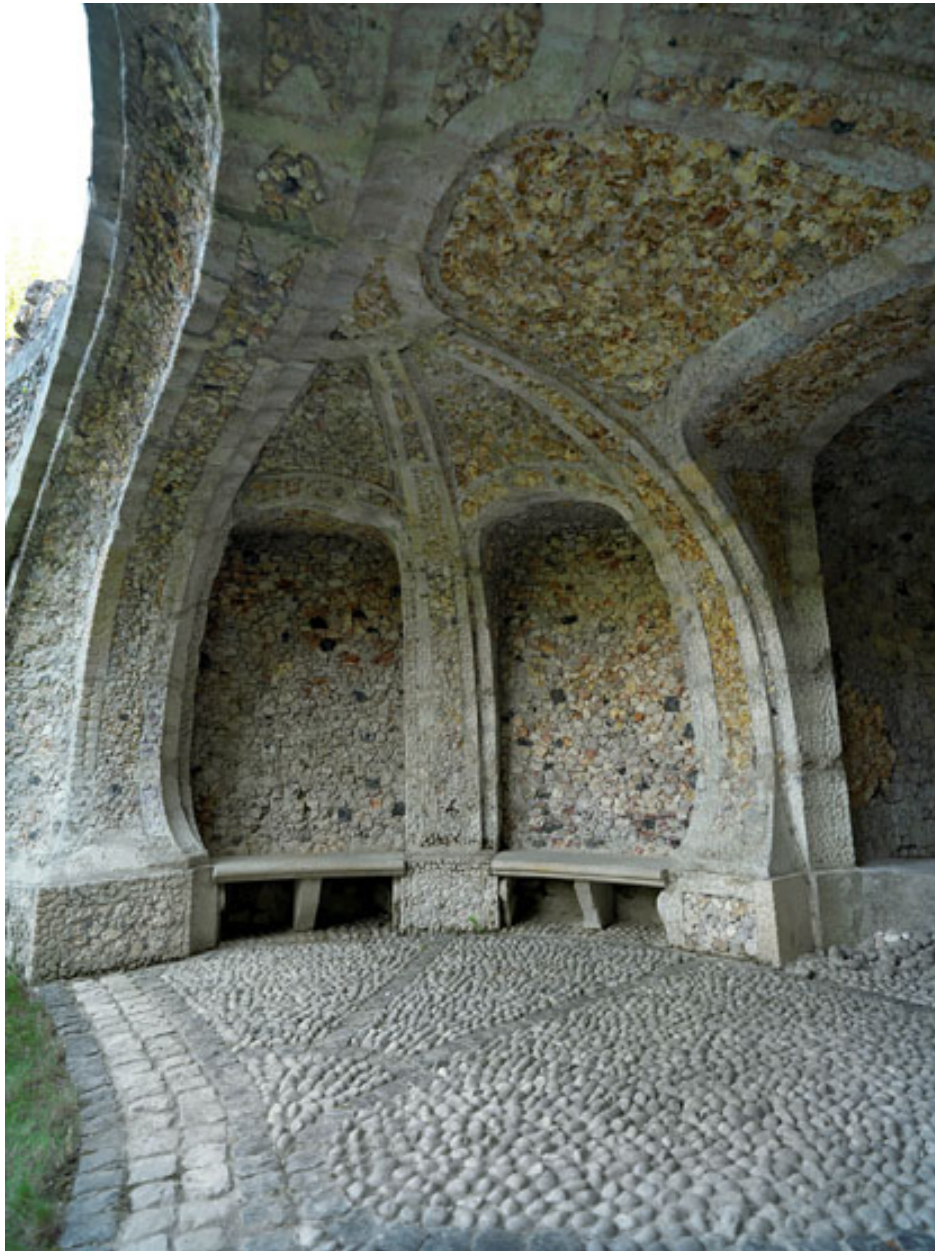
Nymphée de Villeflix, 10 allée de la Grotte, vers 1700. Vue intérieure.
