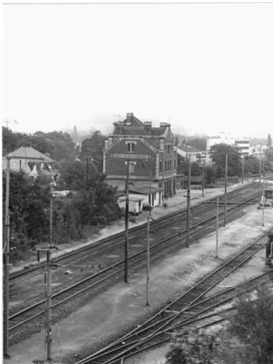
Vue de situation prise du sud-est.
