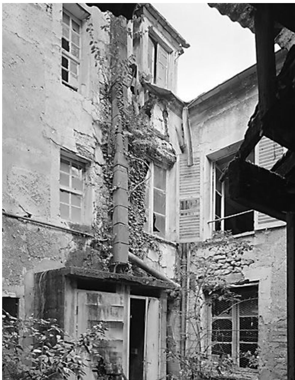
Angle nord-est de la cour : raccord du logis 1 (aile en retour, à gauche) et du logis 3 (à droite).
