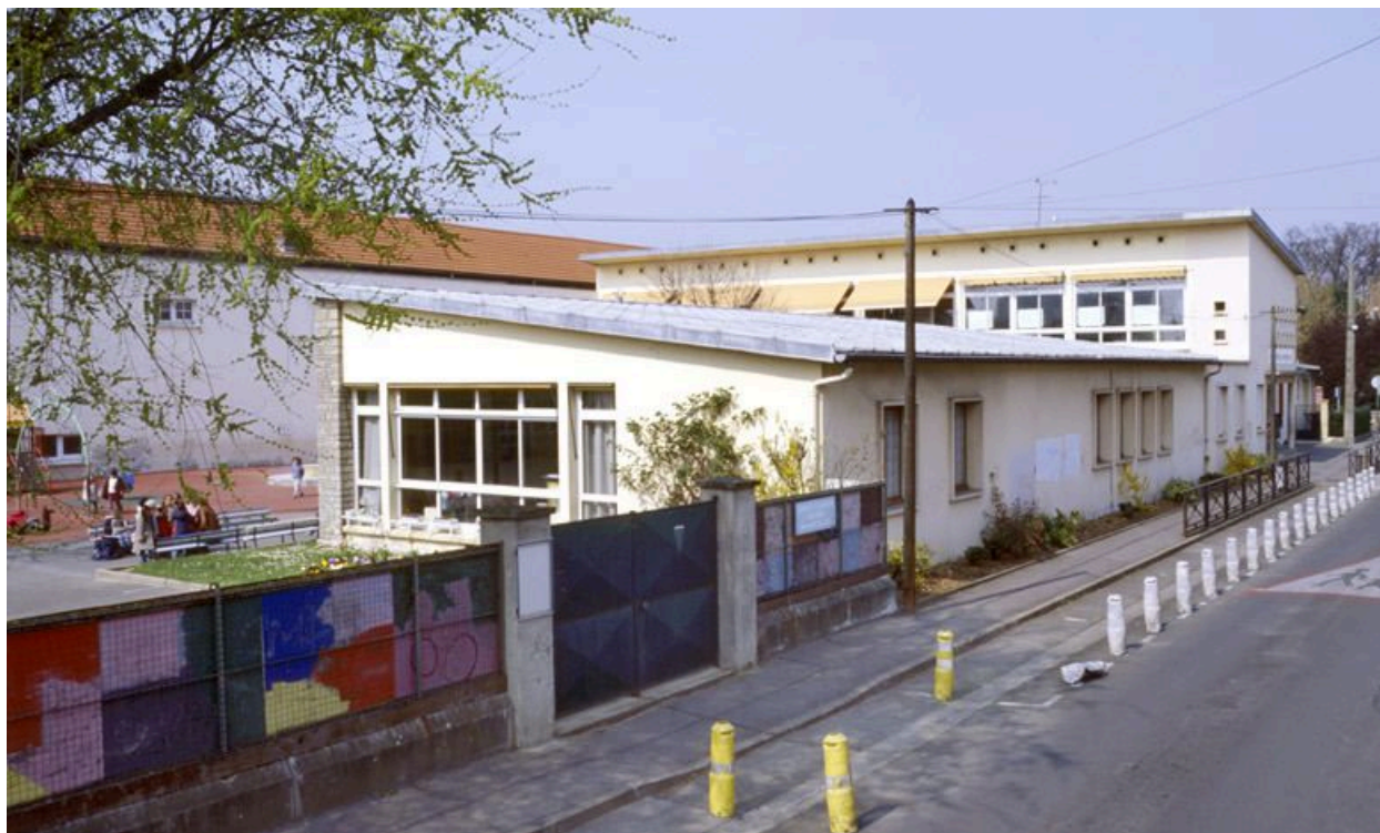
Ecole maternelle Romain-Rolland, 2 rue Paul Bert, construite en 1960 par Julien Heulot (architecte communal). Vue depuis la rue.
