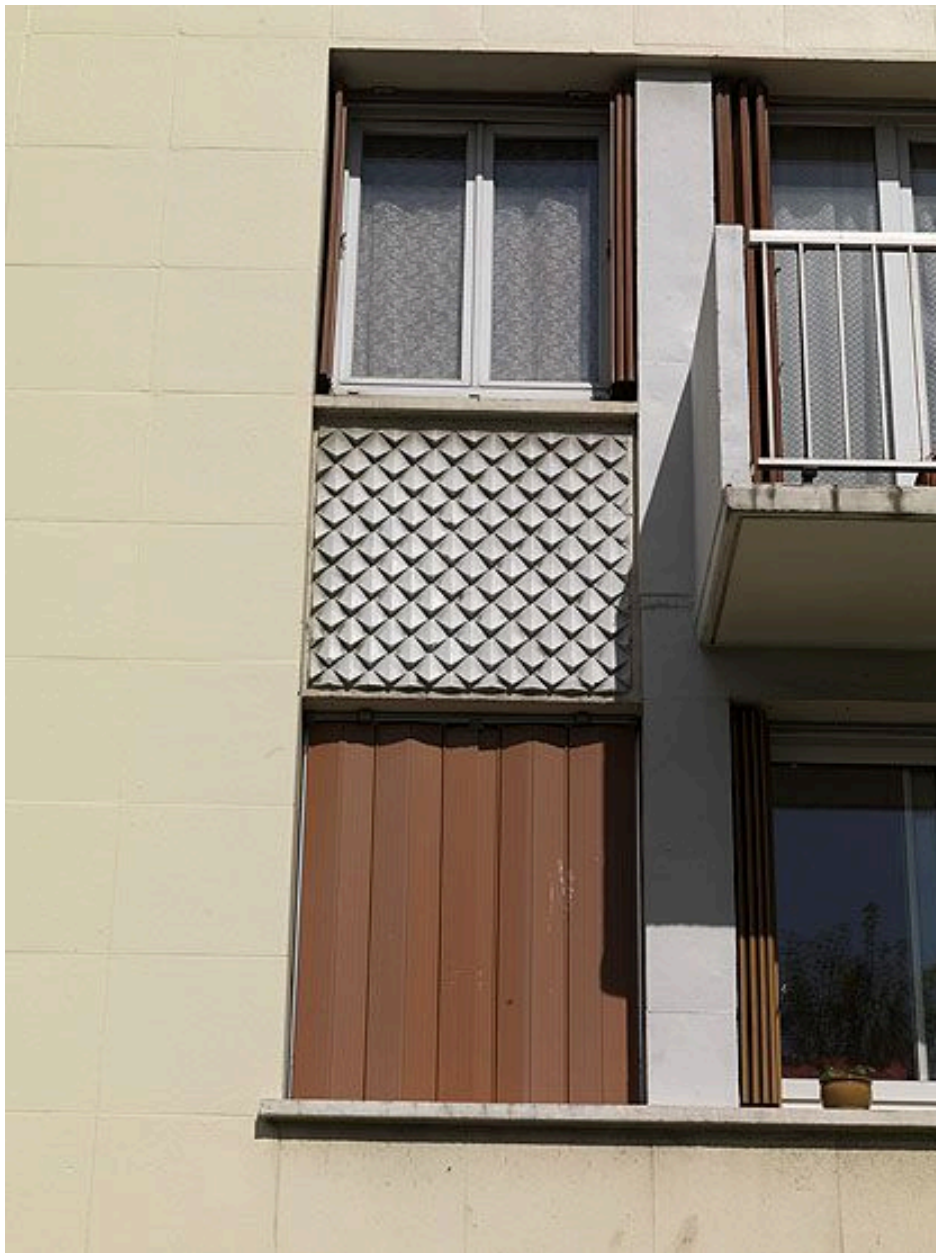
Vitry-sur-Seine, ensemble d'édifices à cour commune, 37 rue Louise-Aglagé-Cretté . Détail des décors sur la façade, entre les fenêtres.
