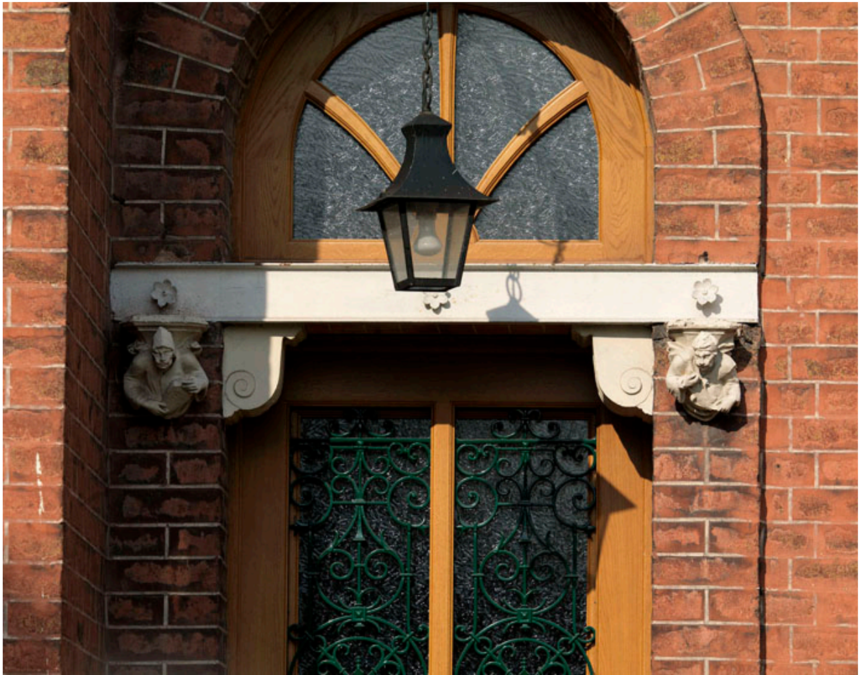
Maison, n°1 Villa des Sureaux : détail du linteau de la porte d'entrée. En métal, il repose sur deux culots en forme de personnage de style néogothique.
