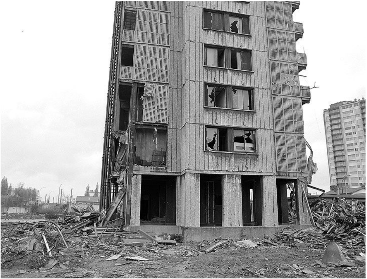
Tour 5, façade sud. Campagne photographique, lors de la destruction du bâtiment en 1976.
