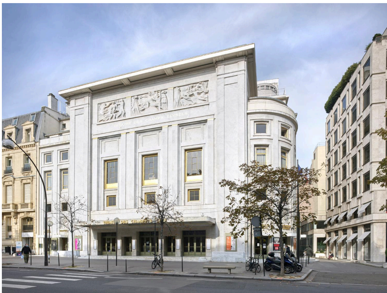
Façade, vue générale
