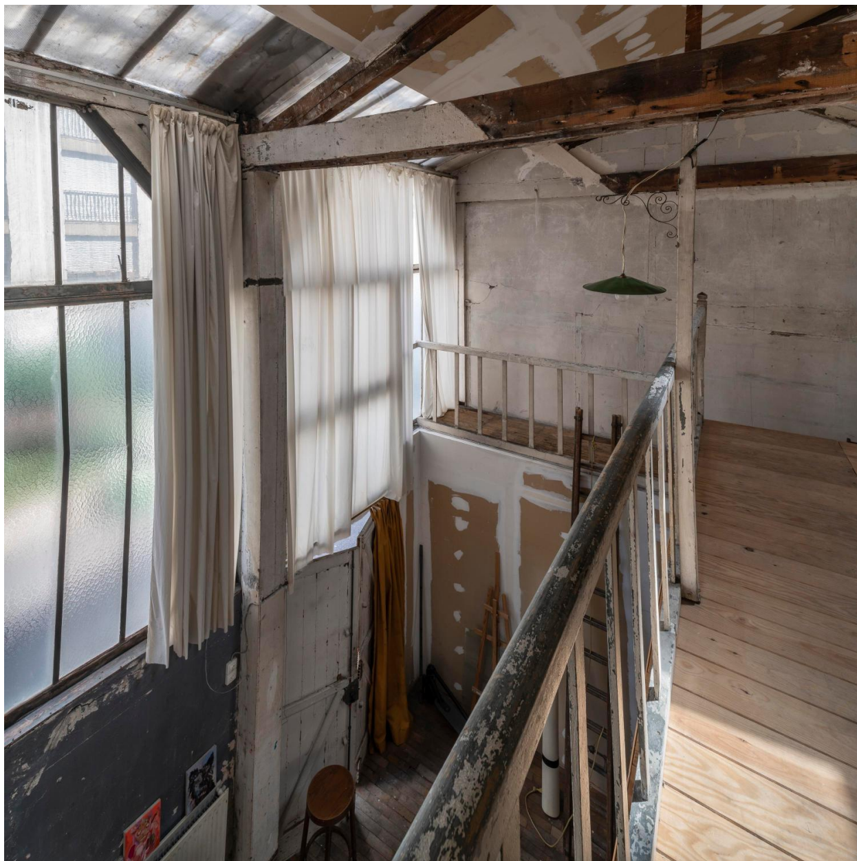
Atelier 11 cité Falguière, mezzanine
