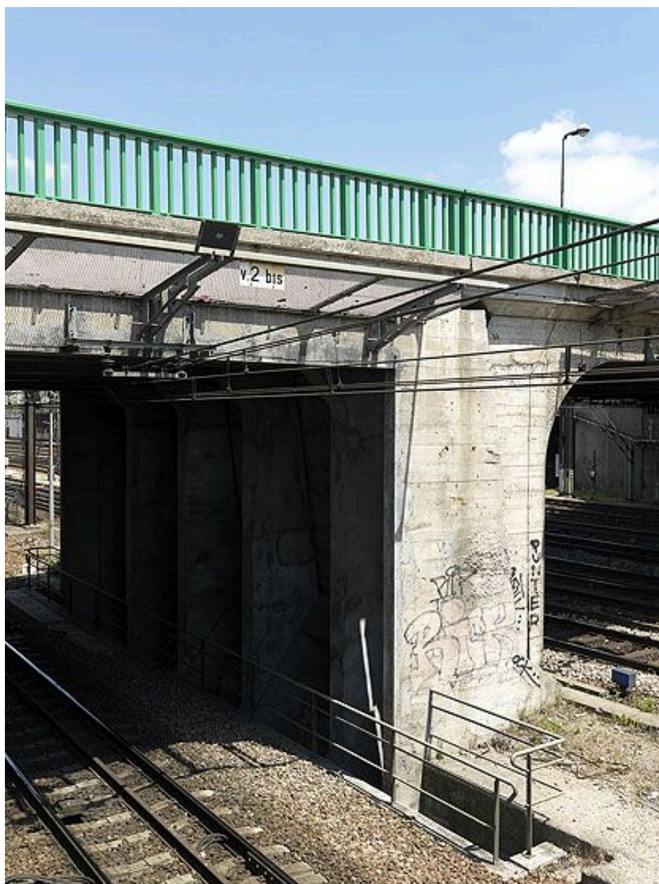
Villeneuve-Saint-Georges. Prolongement du pont de Villeneuve au-dessus des voies de chemin de fer.
