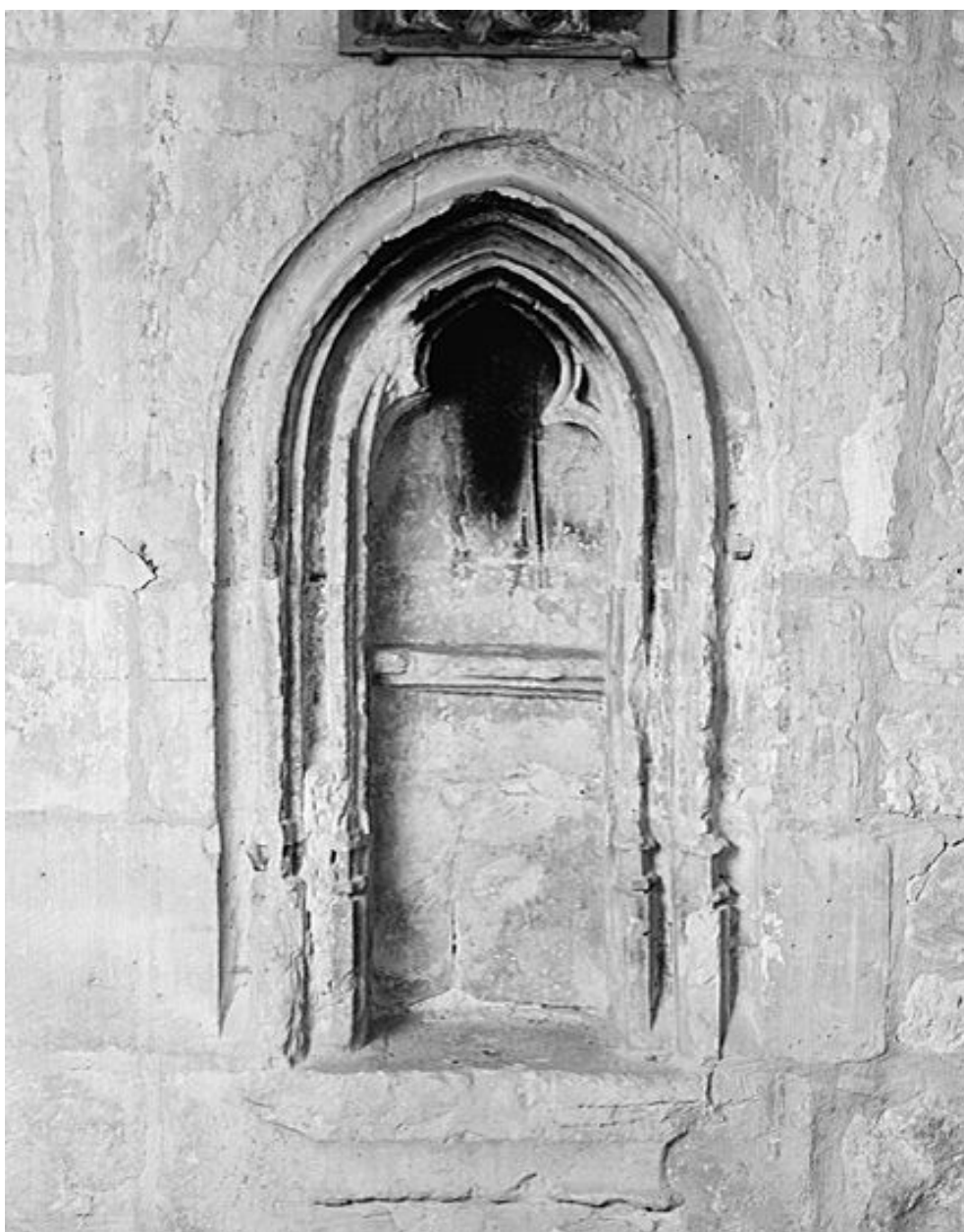
Piscine (lavabo en niche) pratiquée dans le mur sud de l'église.
