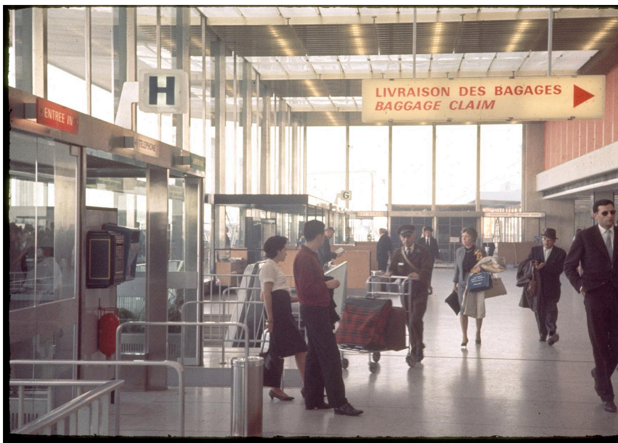
1961, le Grand Hall, rez-de-chaussée.
