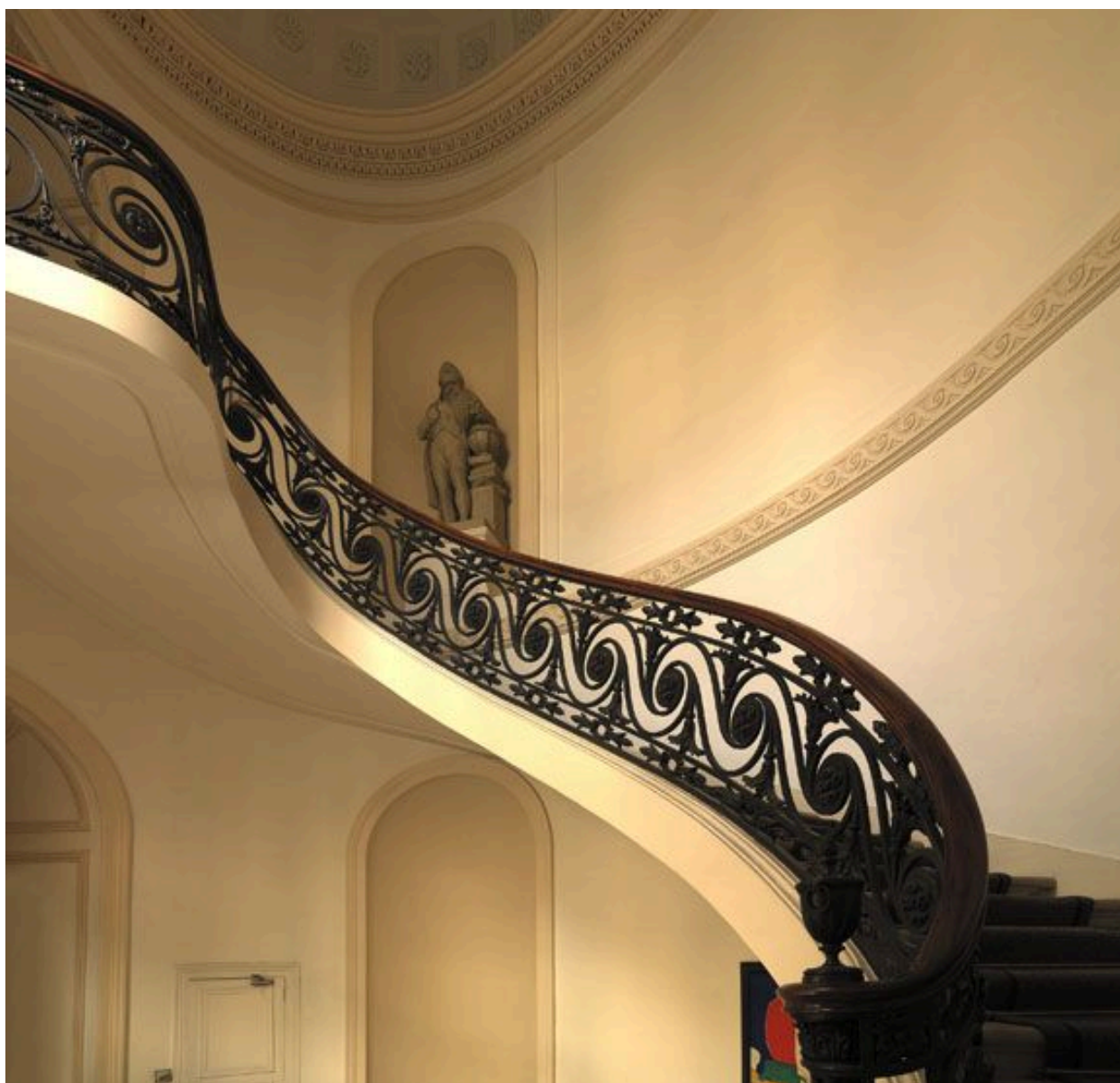
Vue d'ensemble de la rampe.
