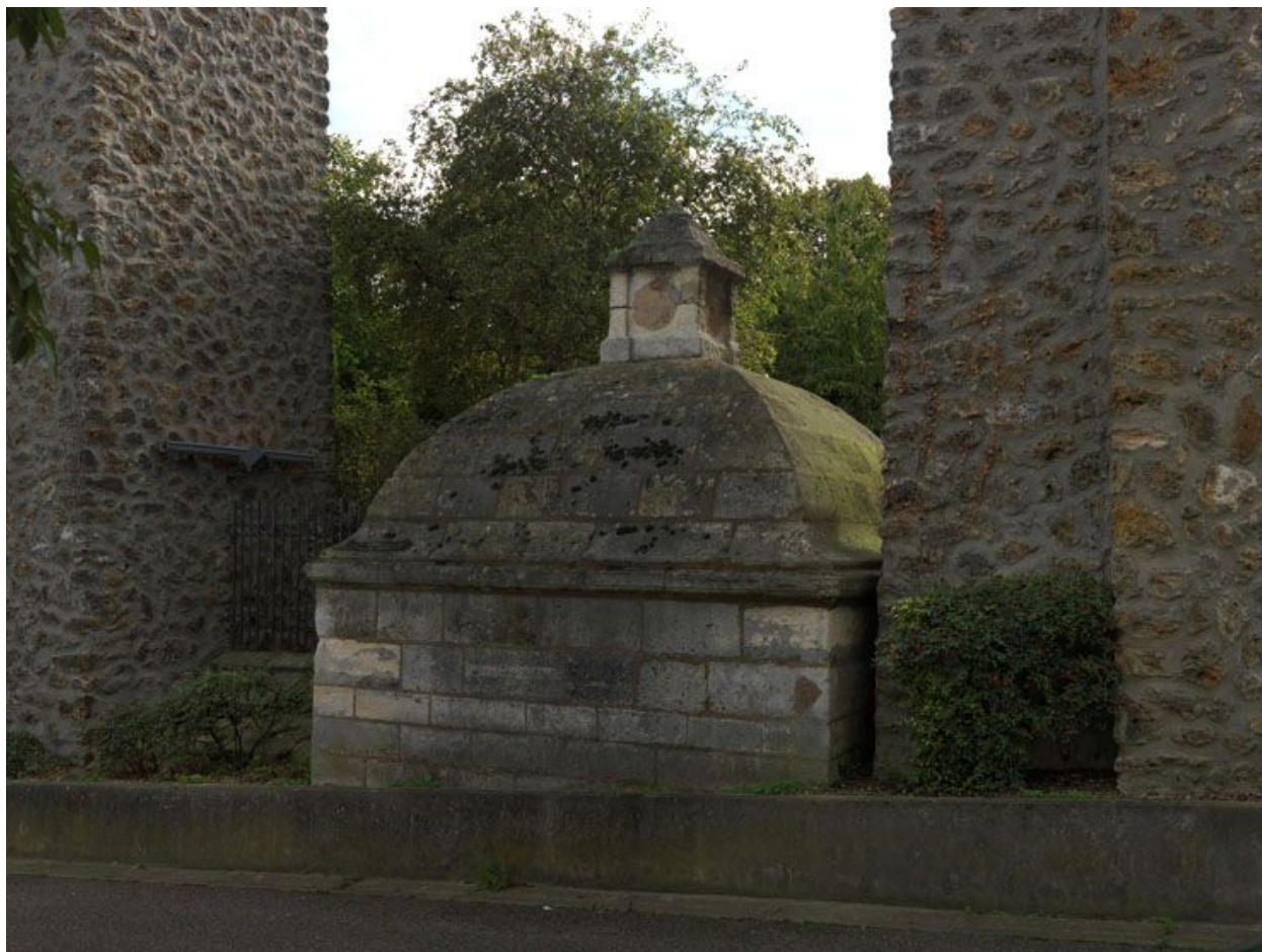
Arcueil, Jacques-Debrosses (boulevard). Vue sur la façade nord du regard XIV.
