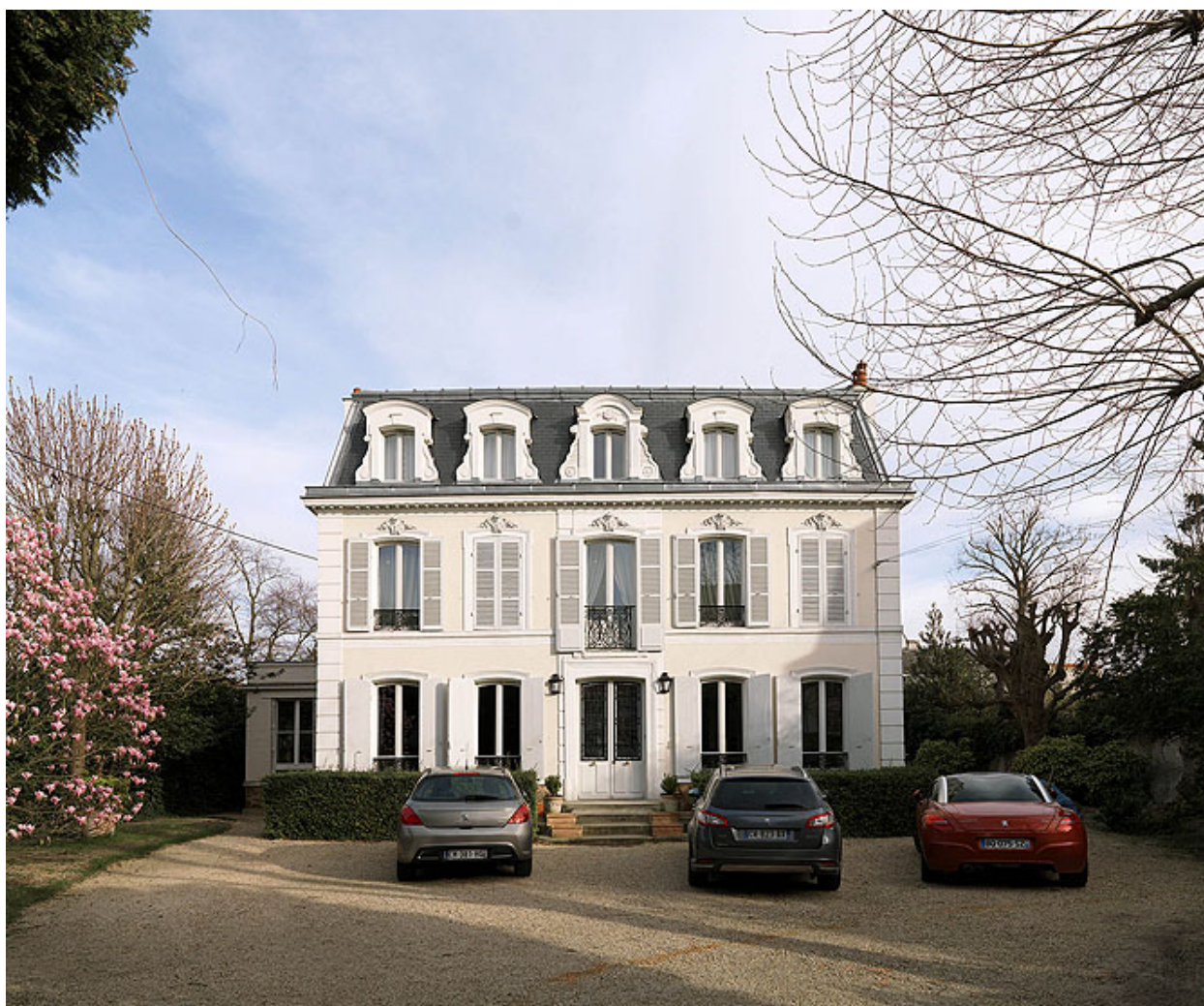
La façade sur cour.
