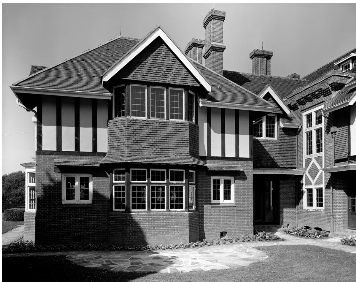
Vue du côté Nord-Ouest.
