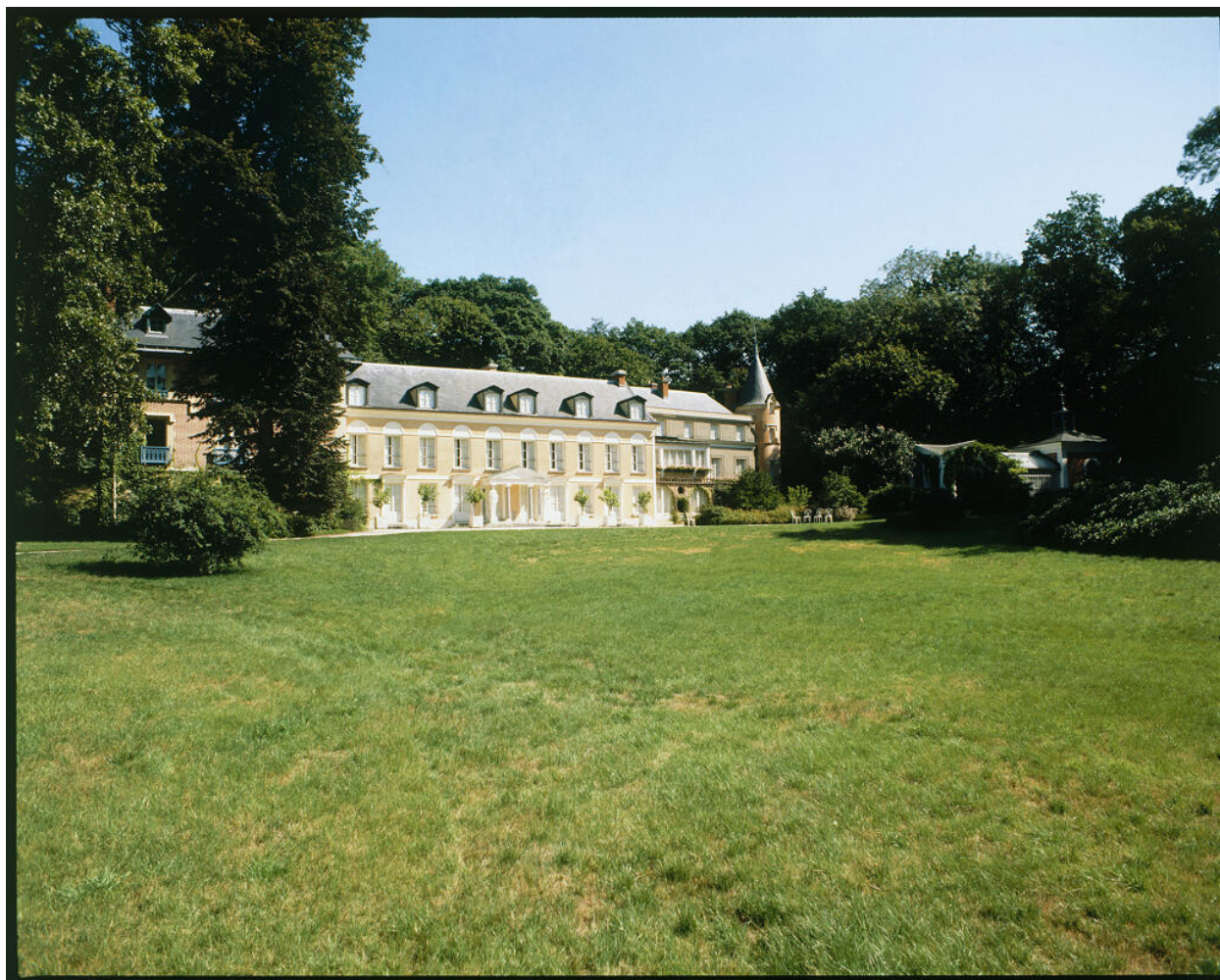
Façade sud. Vue d'ensemble depuis le parc.
