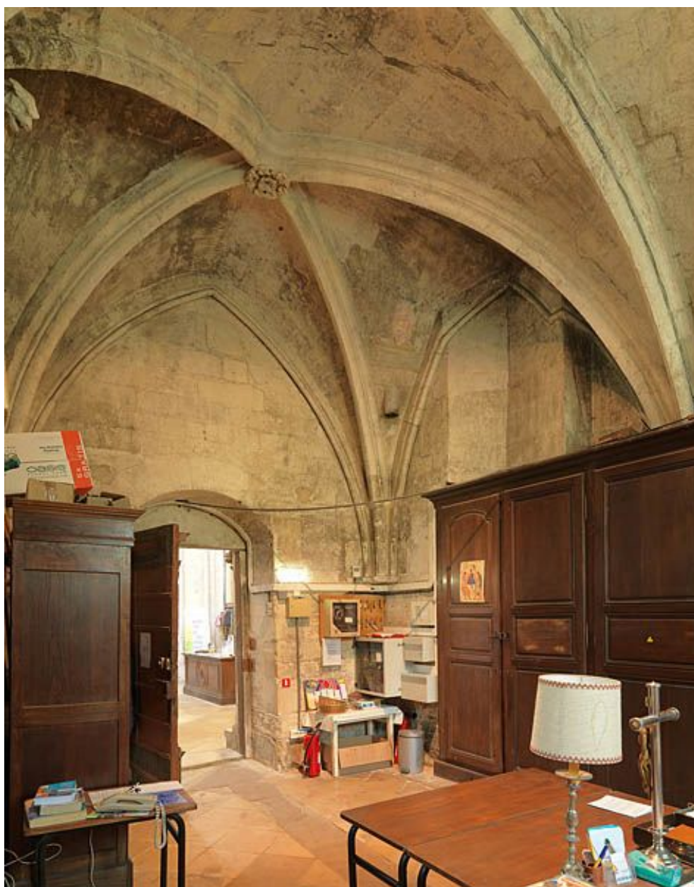
La partie sud-ouest de la sacristie.
