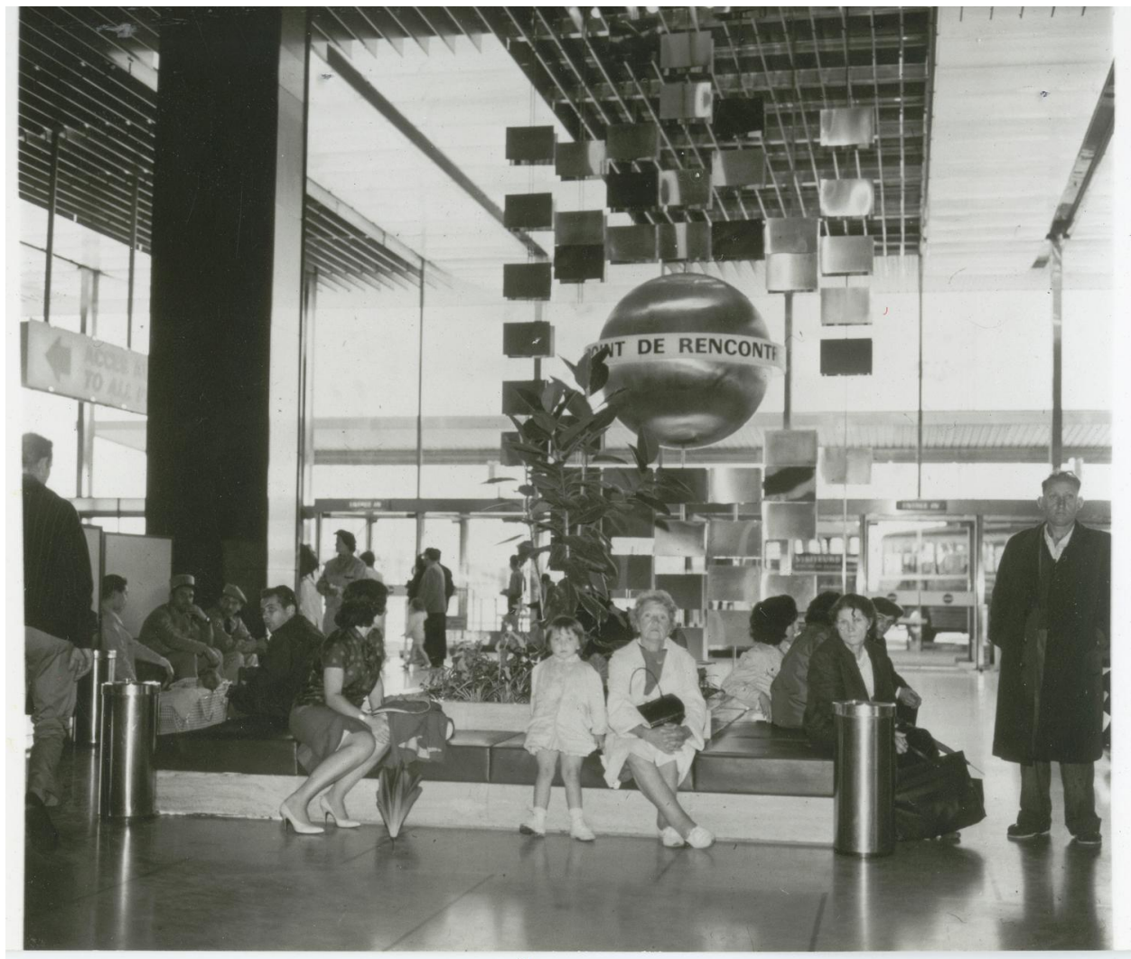
1966, le point de rencontre, rez-de-chaussée.
