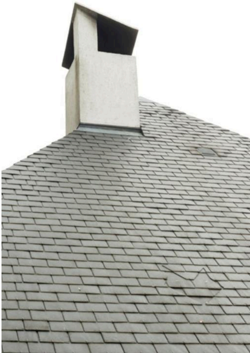
Vue de la façade latérale gauche : détail de la couverture et de la cheminée.
