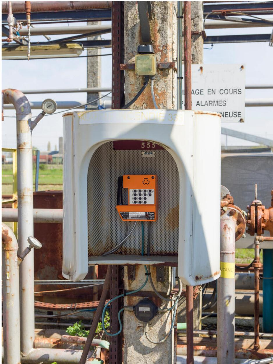
Zone de chargement GPL (Unité 550). Quai de chargement GPL. Généphone ("nouvelle génération") utilisé pour communiquer avec la salle de contrôle sur les opérations en cours, et éventuellement prévenir les secours.
