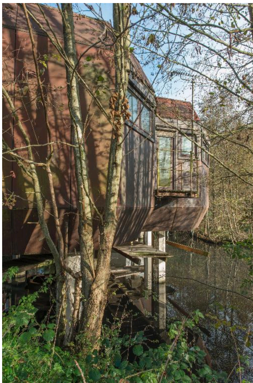
Vue rapprochée des pavillons sur pilotis, côté sud
