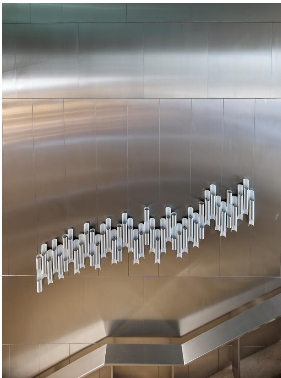
Escalier principal (escalier d'honneur), vue depuis le premier étage. Dessiné par G. Picquenard. Rampe en inox et garde-corps en verre fumé, revêtement en travertin. Luminaire composé par G. Picquenard à partir de tubes individuels préexistants. Les tubes reprennent le dessin de l'escalier. Mur en plaques de métal.
